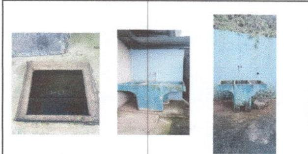
REPARACION DE RED DE DRENAJE Y RED DE AGUA POTABLE Limpieza de fosa séptica de 4 M3, Compra de pilas, Reparacion de drenajes para pilas
